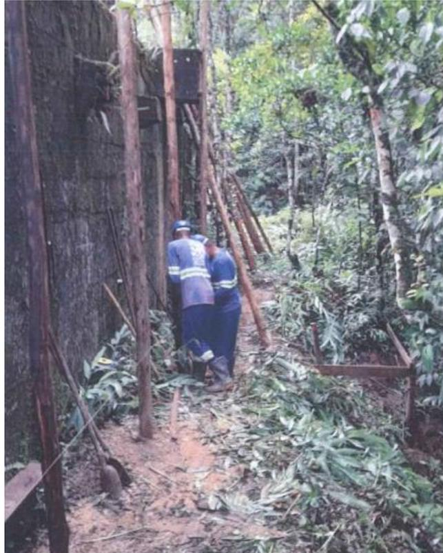
**Foto 3** – Reforço no muro de contenção - Km 063+000
